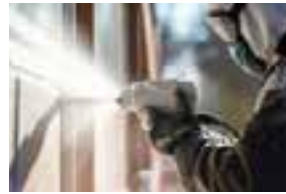
Sandstrahlen zur Lackentfernung
